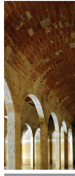
Imatges de l'estat actual del dipòsit d'aigua del rei Martí, a Bellesguard, encara amb la presència d'aigua en alguna part. L'estructura és de columnes de maó i volta catalana. Fotografies de Javier Sardá
