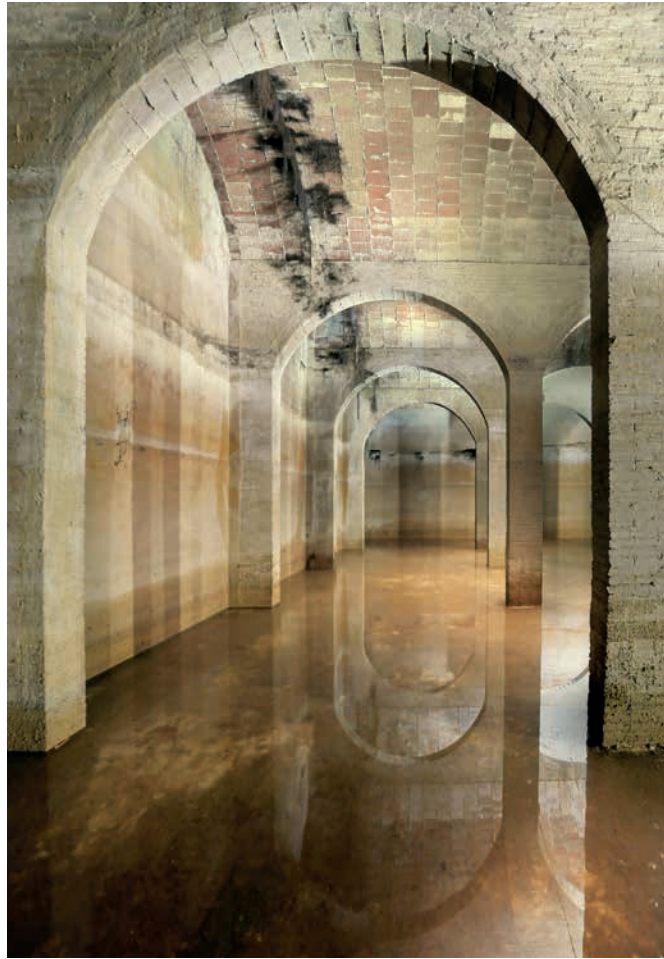
Imatges de l'estat actual del dipòsit d'aigua del rei Martí, a Bellesguard, encara amb la presència d'aigua en alguna part. L'estructura és de columnes de maó i volta catalana. Fotografies de Javier Sardá
