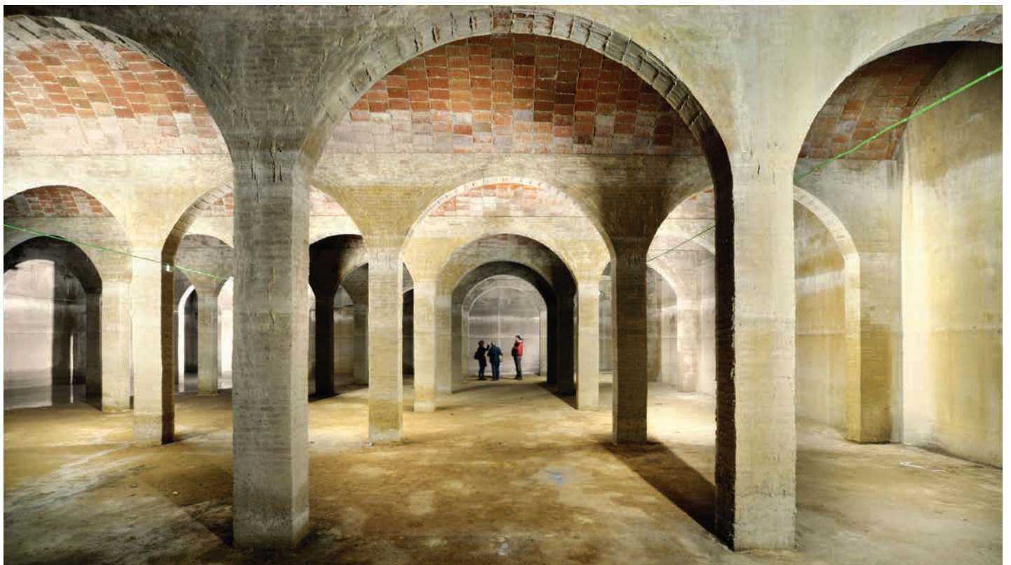
Imatges de l'estat actual del dipòsit d'aigua del rei Martí, a Bellesguard, encara amb la presència d'aigua en alguna part. L'estructura és de columnes de maó i volta catalana. Fotografies de Javier Sardá
