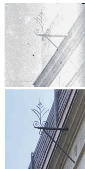
Un objecte de ferro situat a la façana d'una casa, segurament un parallamps, és un element de continuïtat que han captat les dues fotografies
