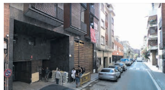
Façana del carrer Ballester 46, on s'han ocupat nou pisos d'una finca
