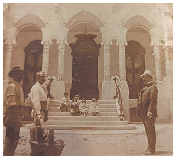
Accés a la casa, des del jardí, per l'esca principal. A la dreta trobem el Sr. Antoni Tosquella i, assegudes a l'escala, les seves filles.
