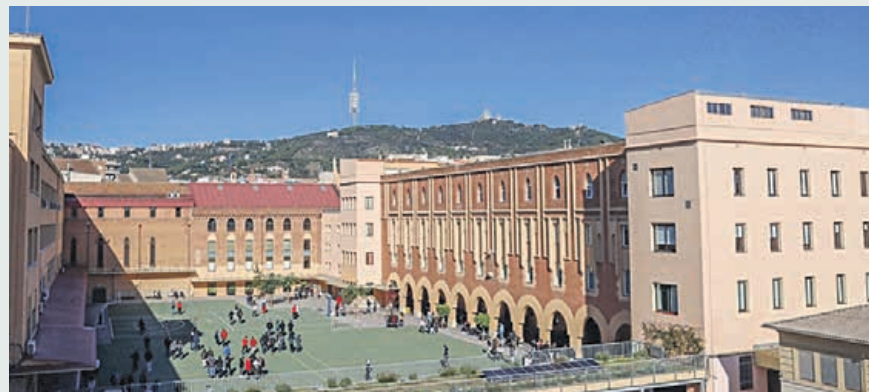
Edifici dels Salesians de Sarrià
