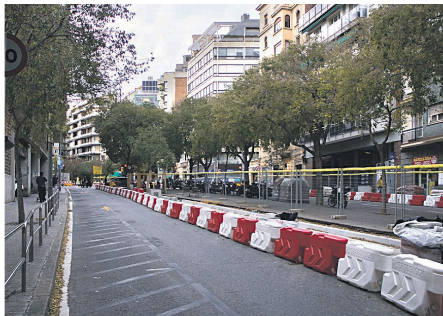
Obres del carril bici de la Via Augusta a l'altura del carrer Madrazo
